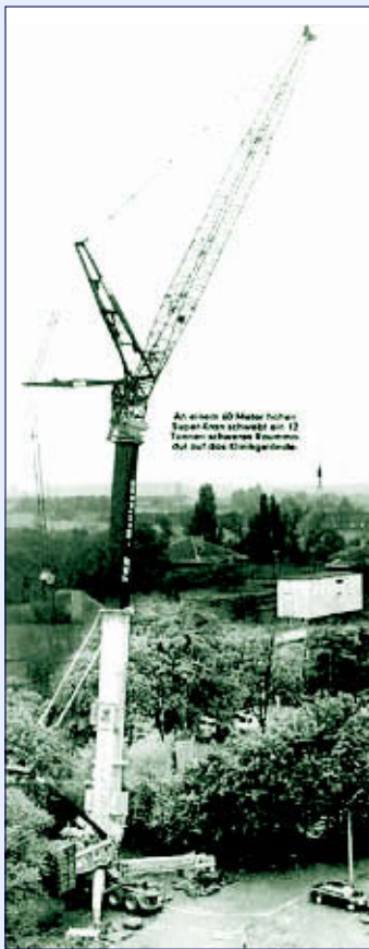
Die ersten Module der neuen Klinik für Herz- und Thoraxchirurgie schwebten per Schwerlastkran am 31. Mai 1995 ein.
