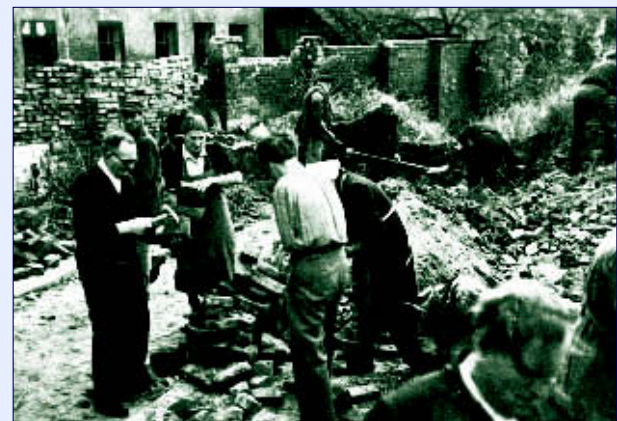
Entrümmerungsarbeiten im Sudenburger Krankenhaus, 1945
