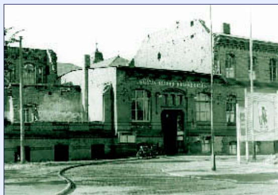
Zerstörter Eingangsbereich (später auch der Eingangsbereich der MAM), 1948
