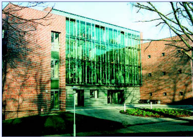
Der Neubau Theoretische Institute, Haus 44, konnte im Jahr 2000 nach nur 14-monatiger Bauzeit übergeben werden.
