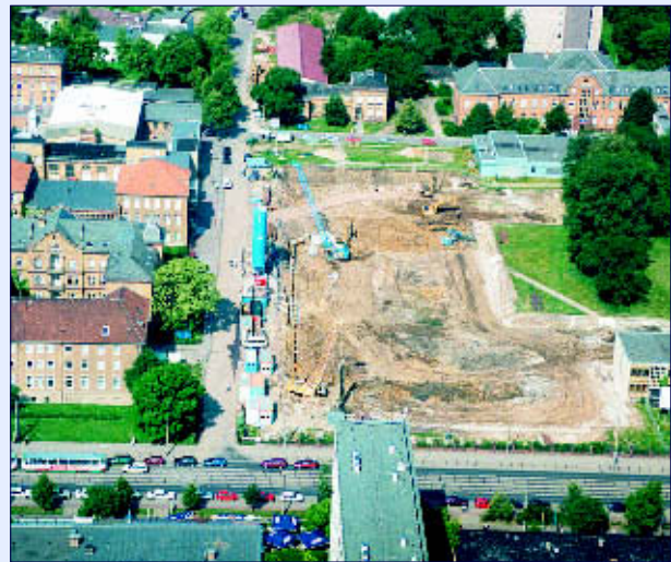
Baugrube für den ersten Bauabschnitt des Klinikneubaus, Haus 60
