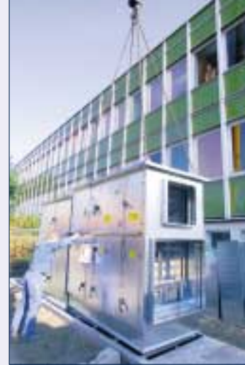
Am 18. September wurde die Belüftungsanlage angeliefert.
