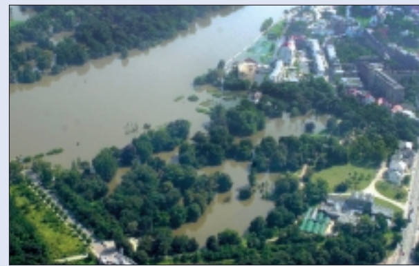
Auch in den Stadtteilen Buckau und Salbke hinterließ das Hochwasser große Schäden. Luftbild: Elke Lindner
